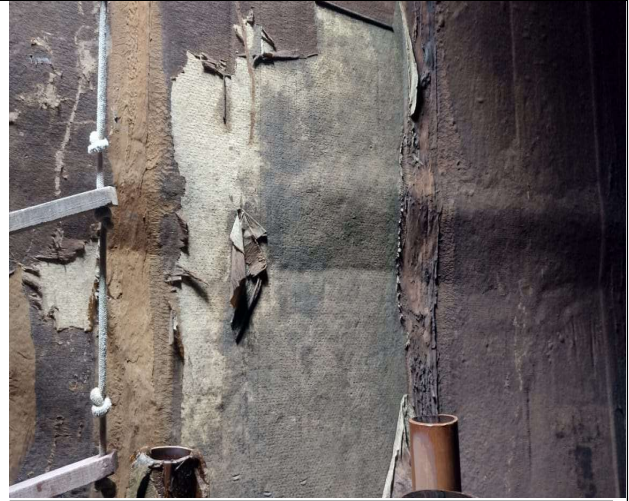
MANTA DESPLACANDO EM 90% DA AREA APLICADA.
