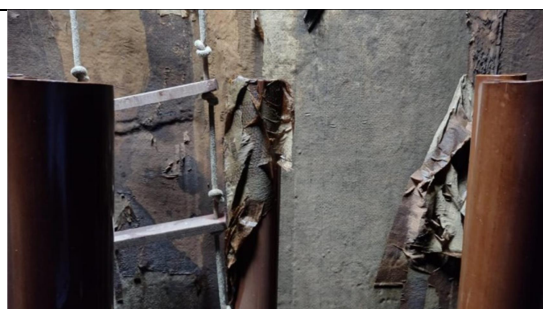
Parede Caixa de Água
