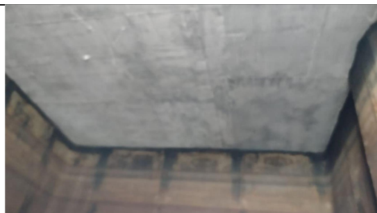
Teto Caixa de Água
