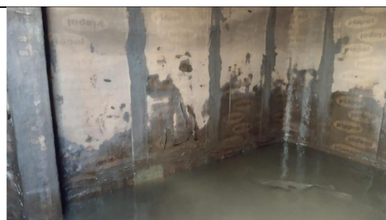
Parede Caixa de Água
